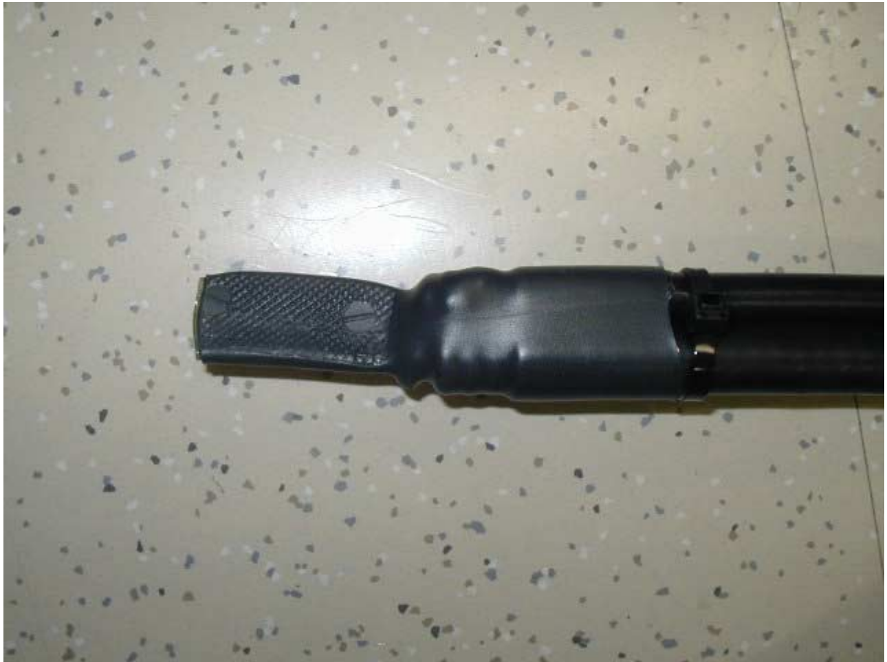
Tehonjakojen päät suojattu sukalla. Ei ole täysin vesitiivis
